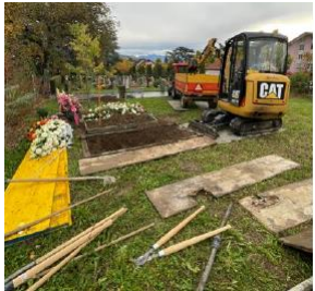
Phase 1 : préparation chantier
