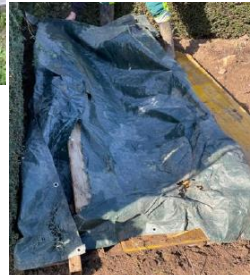
Phase 3 : Fermeture de la fouille
