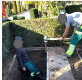
Phase 2 : Réalisation de la tombe et étaillage
