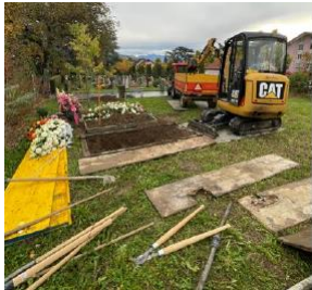
Phase 1 : préparation chantier
