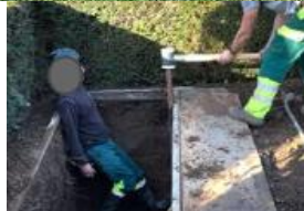
Phase 2 : Réalisation de la tombe et étagage
