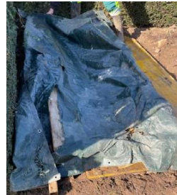
Phase 3 : Fermeture de la fouille
